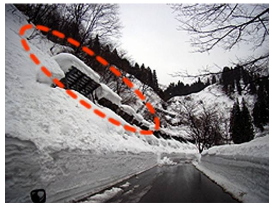
・巻きだれ現象 (雪崩予防柵からの雪の張り出し)
